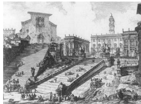
Treppe zum Capitol
