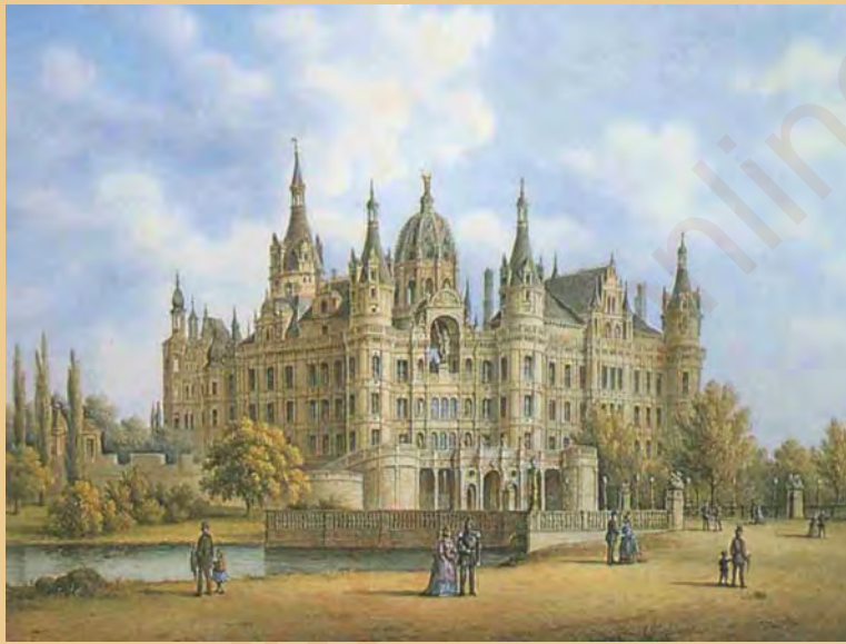
Schloss Schwerin nach dem Umbau im 19. Jh.
